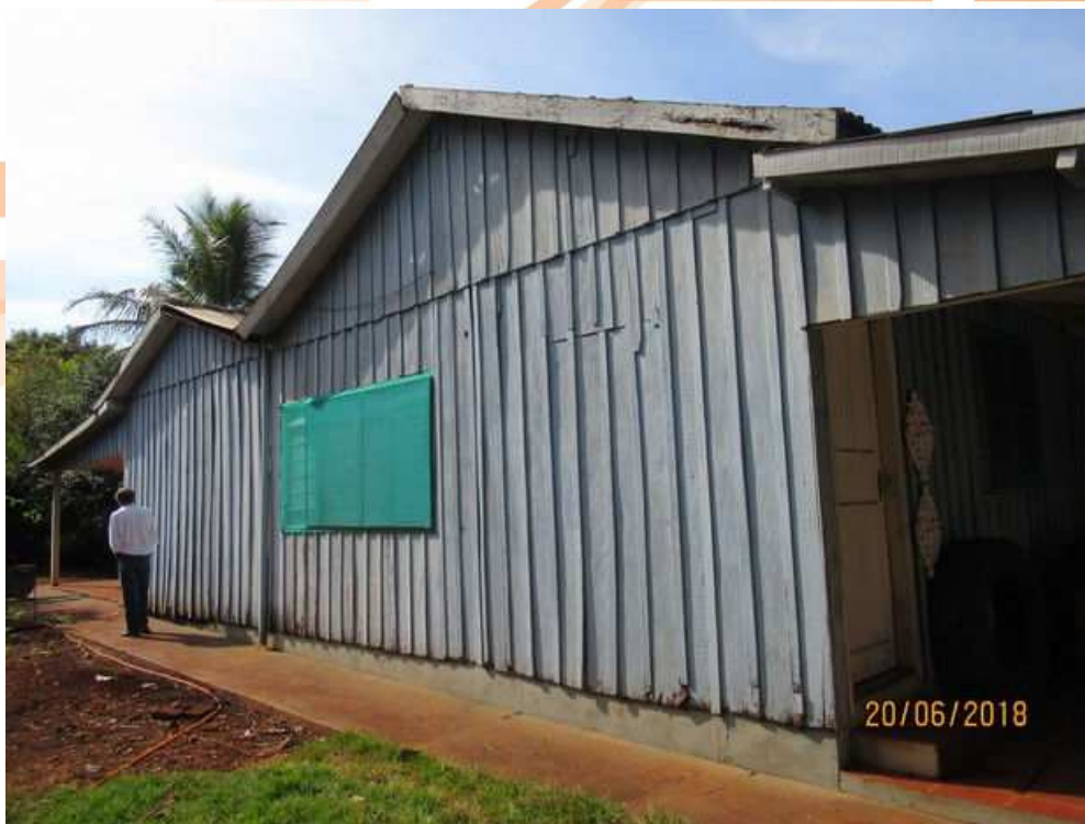
Imagem 08: Residência de madeira – Construção 01.
