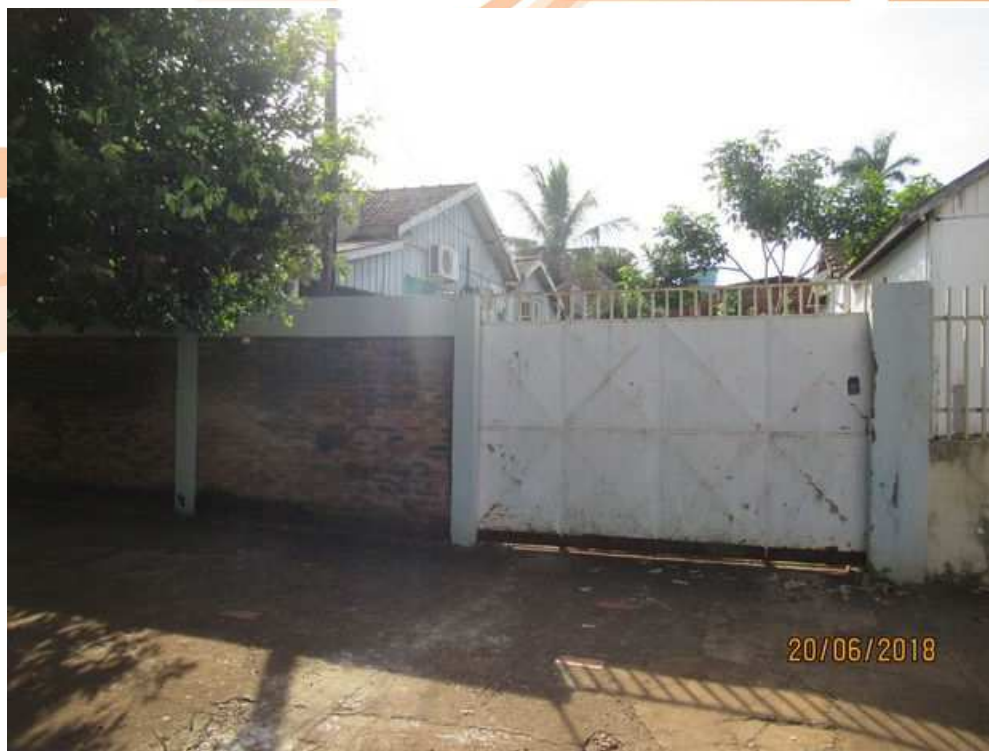
Imagem 06: Fachada do imóvel e portão de veículos – Construção 01.
