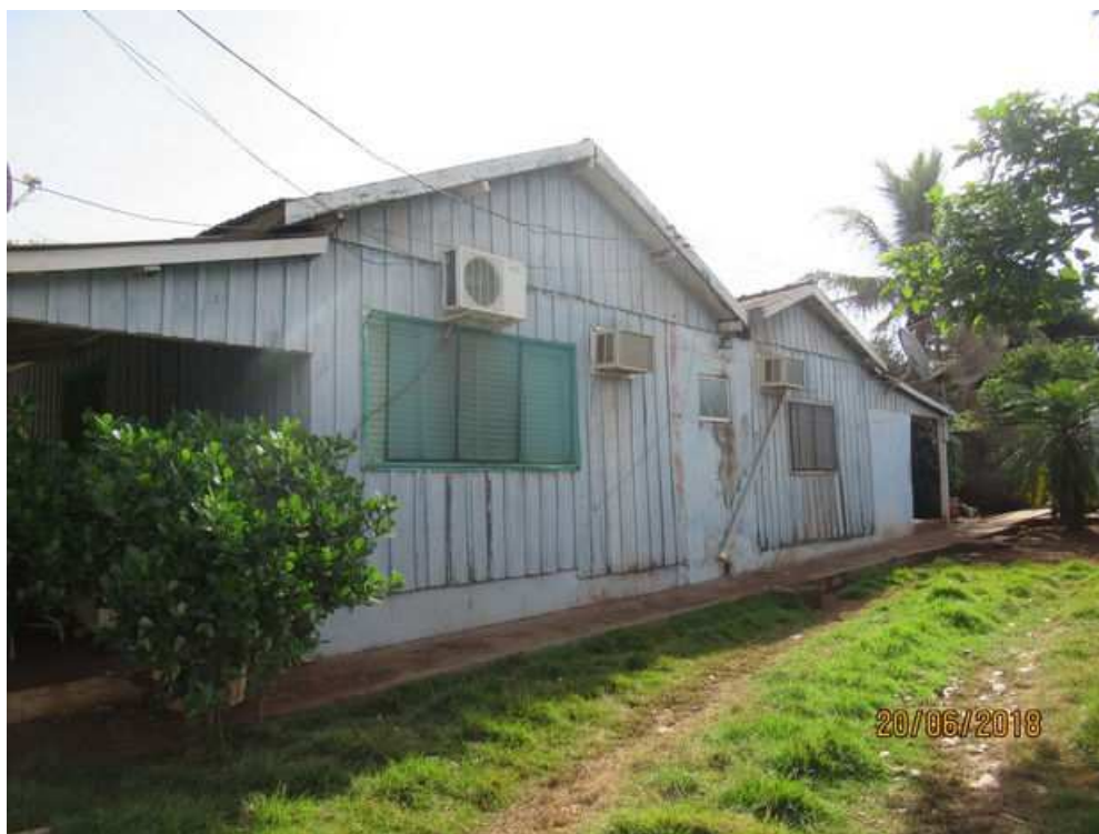
Imagem 11: Residência de madeira – Construção 01.
