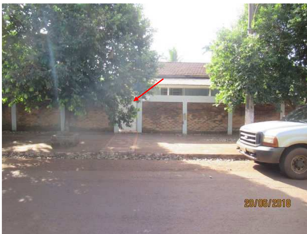
Imagem 05: Fachada do imóvel e portão de pedestres – Construção 01.
