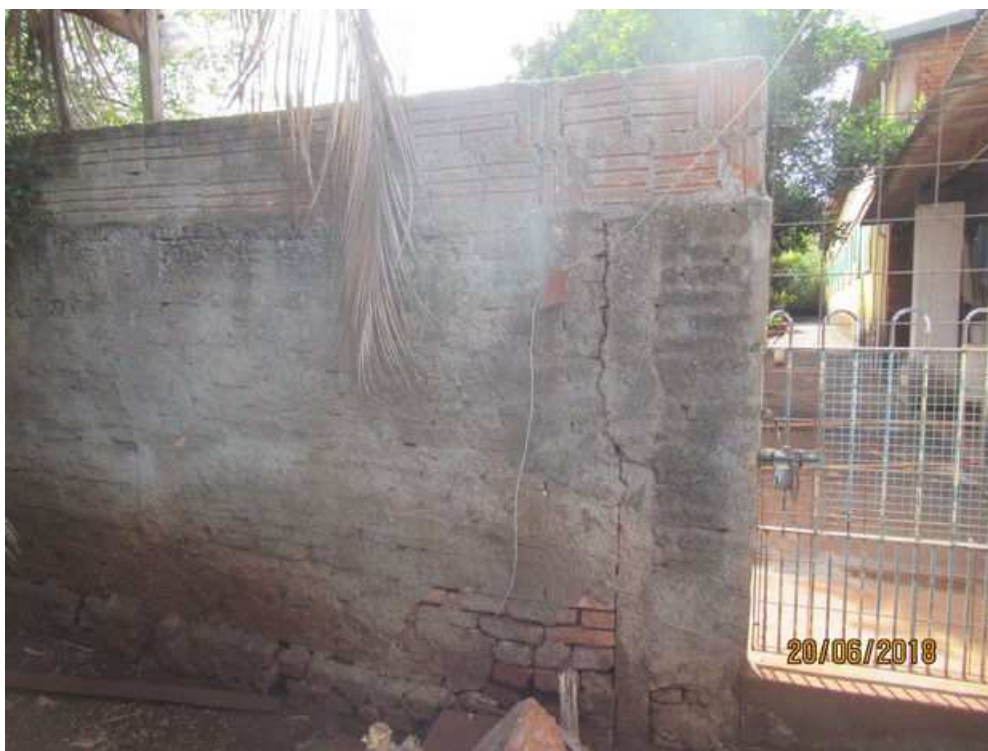
Imagem 19: Muro de divisa com o lote "ABE".
